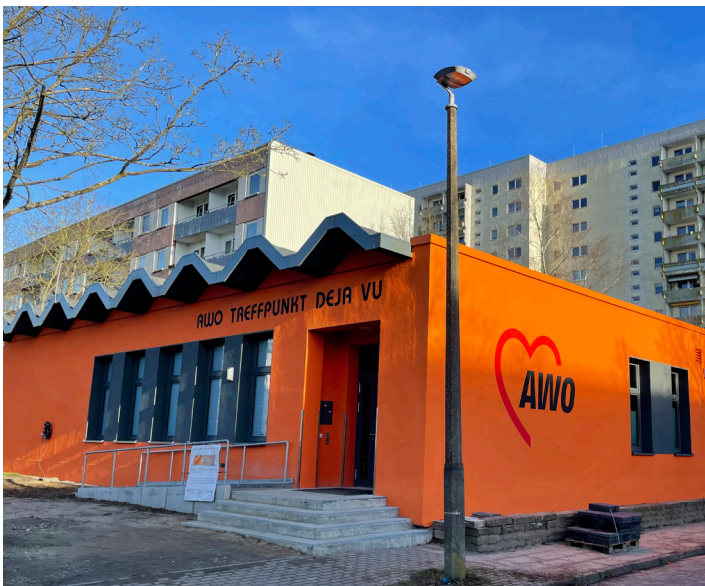
In leuchtendem Orange erstrahlt der Jugend- und Freizeittreff „Deja vu“ nach der Sanierung. © Landeshauptstadt Schwerin/Mareike Diestel
